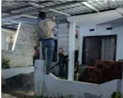
Gambar 5. Pemasangan IP Camera CCTV
